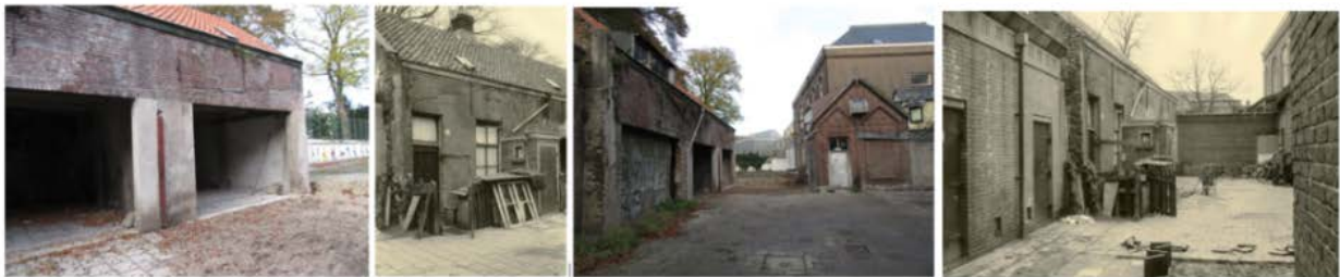
Foto: Te restaureren Armenhuisjes in Breda
